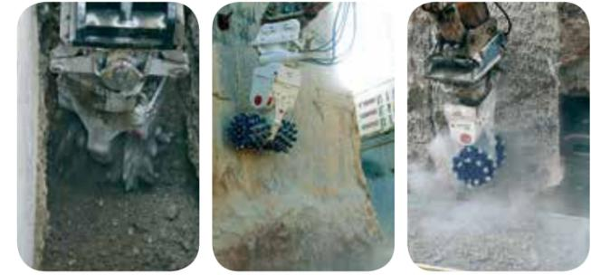
Dans des applications telles que le creusement de tunnels ou les travaux de finition, les unités de rotation permettent de réduire le coût d'exploitation jusqu'à 50%, grâce à la précision de finition et des taux de production élevés.
